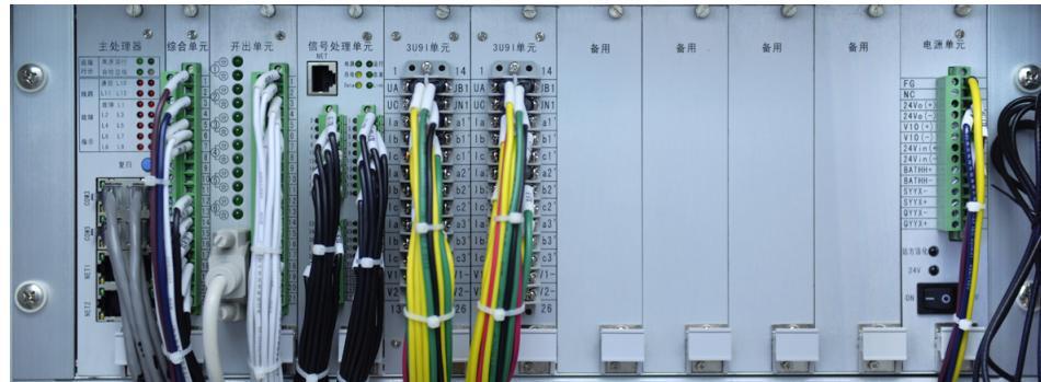
电缆“三遥”终端即站所终端，站所终端是安装在配电网开关站、配电室、环网单元、箱式变电站等处的配电终端。可与配电网自动化主站和子站系统配合，实现多条线路电量的采集、控制和保护功能，并能快速实现故障区域定位、隔离及非故障区域恢复供电，提高供电可靠性。YHK 系列配网自动化装置以高性能 32 位微处理器为硬件开发平台，以嵌入式实时操作系统为软件开发平台。产品具有稳定可靠、高性能、高精度、低成本、易安装等特点。
